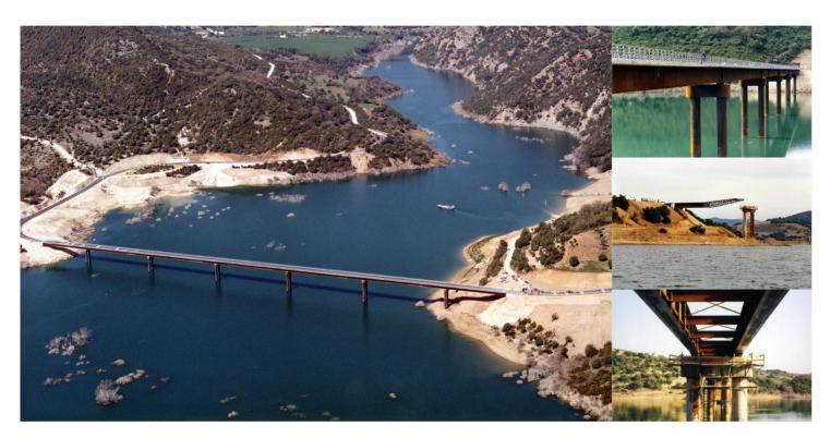
El puente del Picado tiene una longitud total de 450,00 m, con una luz máxima de 70,00 m y un canto total de 2,30 m. El tablero se compone de dos vigas metálicas con losa superior hormigonada sobre prelosas. Las pilas están constituidas por dos pilas pilote de 1,60 m de diámetro, con alturas entre 23,00 m y 35,00 m.
